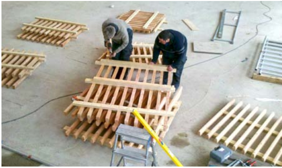
Bis auf eine Höhe von 3 m erhielten die Elemente eine zusätzliche Verstärkung, um die Lasten aus einem Giraffenanprall besser zu verteilen
