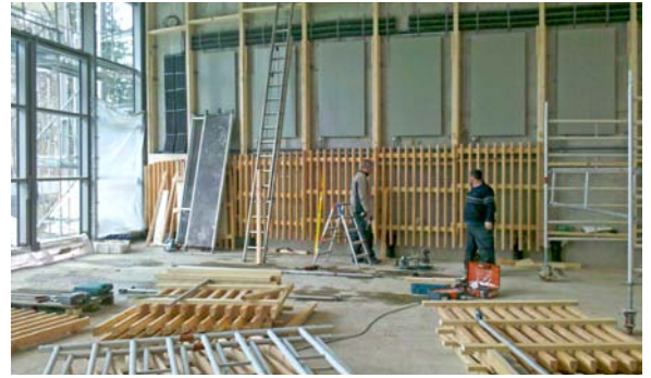
Die Leitungen der Gebäudetechnik und die Heizkörper sind installiert, die tragende Holzkonstruktion wurde hierfür mit Aussparungen versehen. Die horizontal montierten Holzriegel dienen zur Aufnahme der Horizontallasten aus dem Lastfall „Giraffenjuckreiz“
